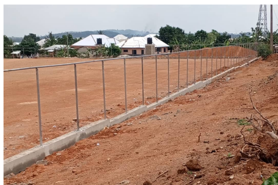
Sportplatz im Bau
